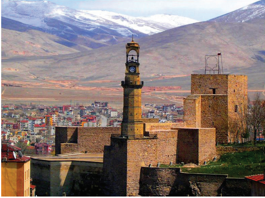
Resim 5.9 İç Kale duvarları ve Saat Kulesi
