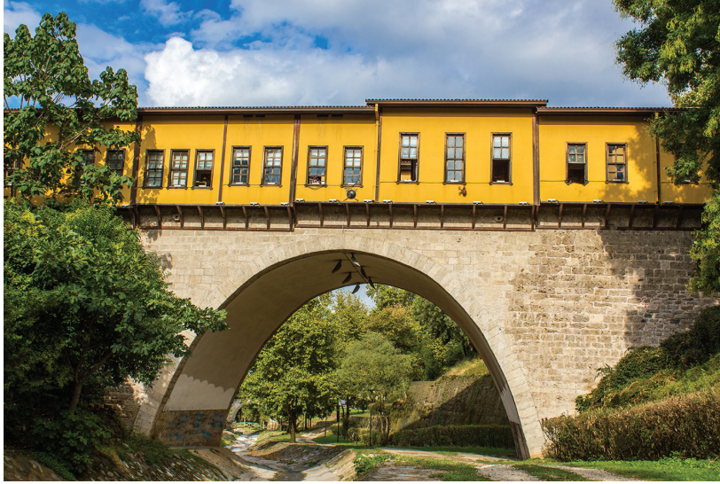
Resim 6.7 Bursa Irgandı Köprüsü
