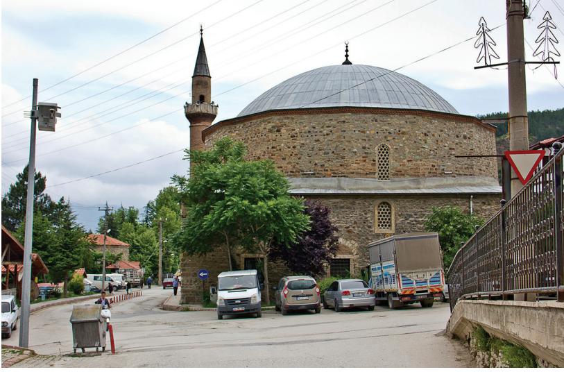
Resim 6.16 Mudurnu Yıldırım Camii
